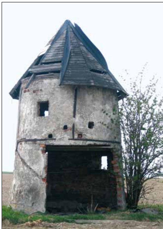
Balerův větrák – stav v r. 2006 před začátkem oprav.
