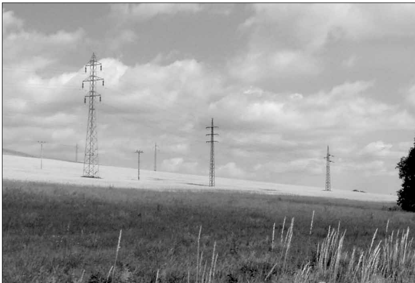
Přehlídka elektrických sloupů na Hvězdové.
